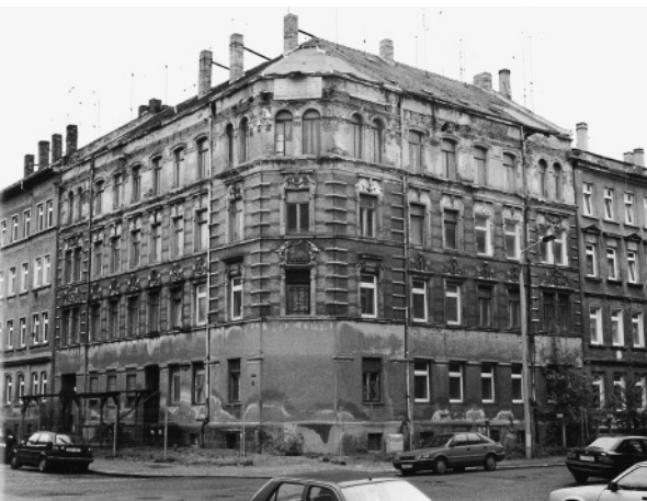
Gründerzeitbebauung in Leipzig-Gohlis vor und nach der Sanierung
