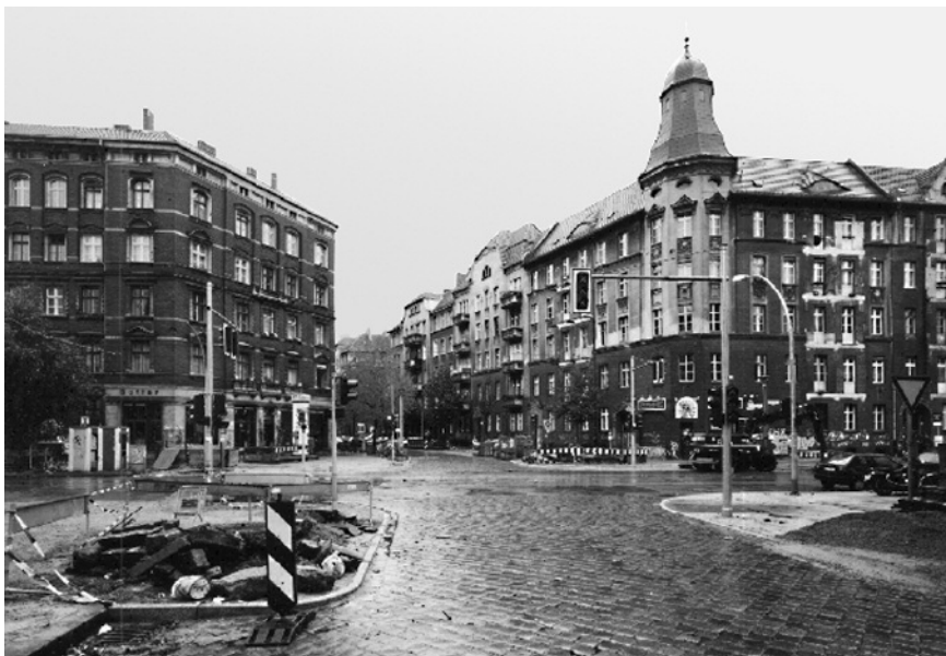
Die Wohnanlage „Bremer Höhe“ in Berlin-Prenzlauer Berg, Pappelallee
