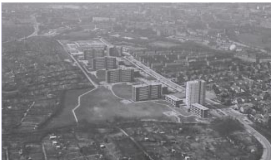
Wohnsiedlung in Kiel-Ellerbek, erbaut 1972/73
