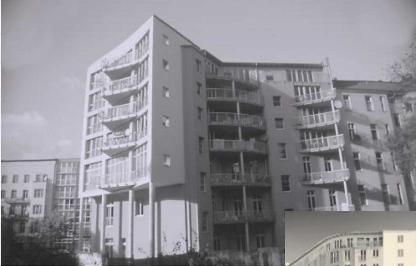
Südostansicht: Anbau, Aufstockung und Balkone
