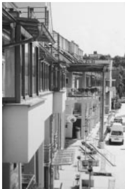
Abb. 3: Laubengänge und barrierefreie Erschließung im Kemptener Projekt
