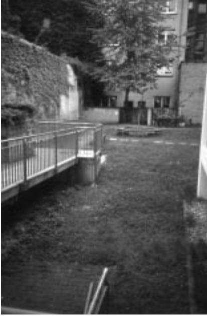
Abb. 4: Barrierefreie Erschließung mit Umwegen (Saarbrücken)
