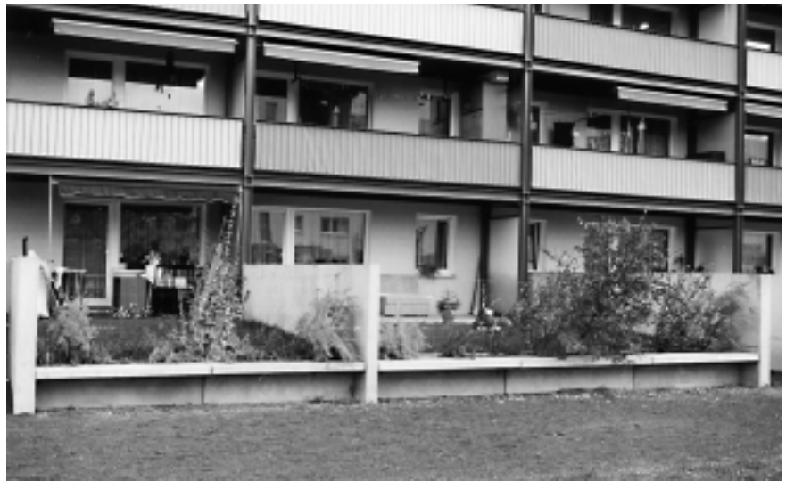
Leinefelde-Südstadt: Privat nutzbare Gartenterrassen in umgebauten Beständen einer Großwohnsiedlung (Foto: Stefanie Rößler, Oktober 2002)
