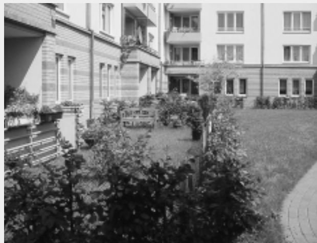
Ein Tor in der Balkonbrüstung ermöglicht den direkten Zugang in den Mietergarten. Die klare Zonierung garantiert eine Ablesbarkeit der Nutzungen und vermeidet Konflikte
