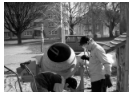
Kinder mischen Beton auf der Baustelle für ihren Spielplatz
