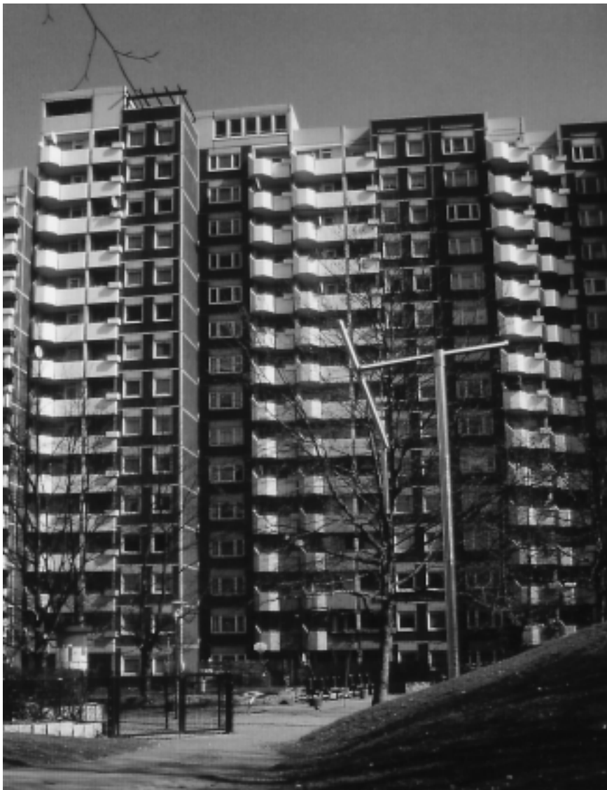
Abb. 1: Hamburg, Lenzsiedlung. Innenhof
