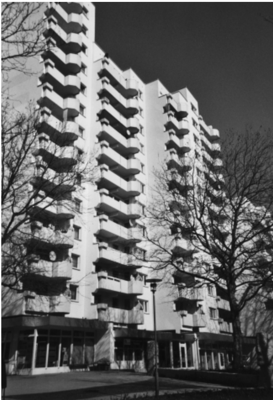
Abb. 3: Hamburg, Lenzsiedlung. Sanierte Fassaden
