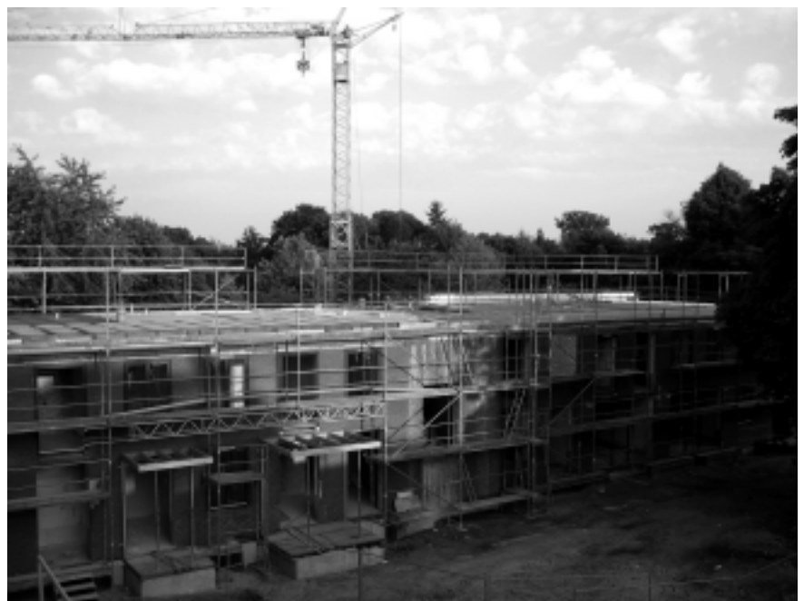
... während des Umbaus ...
