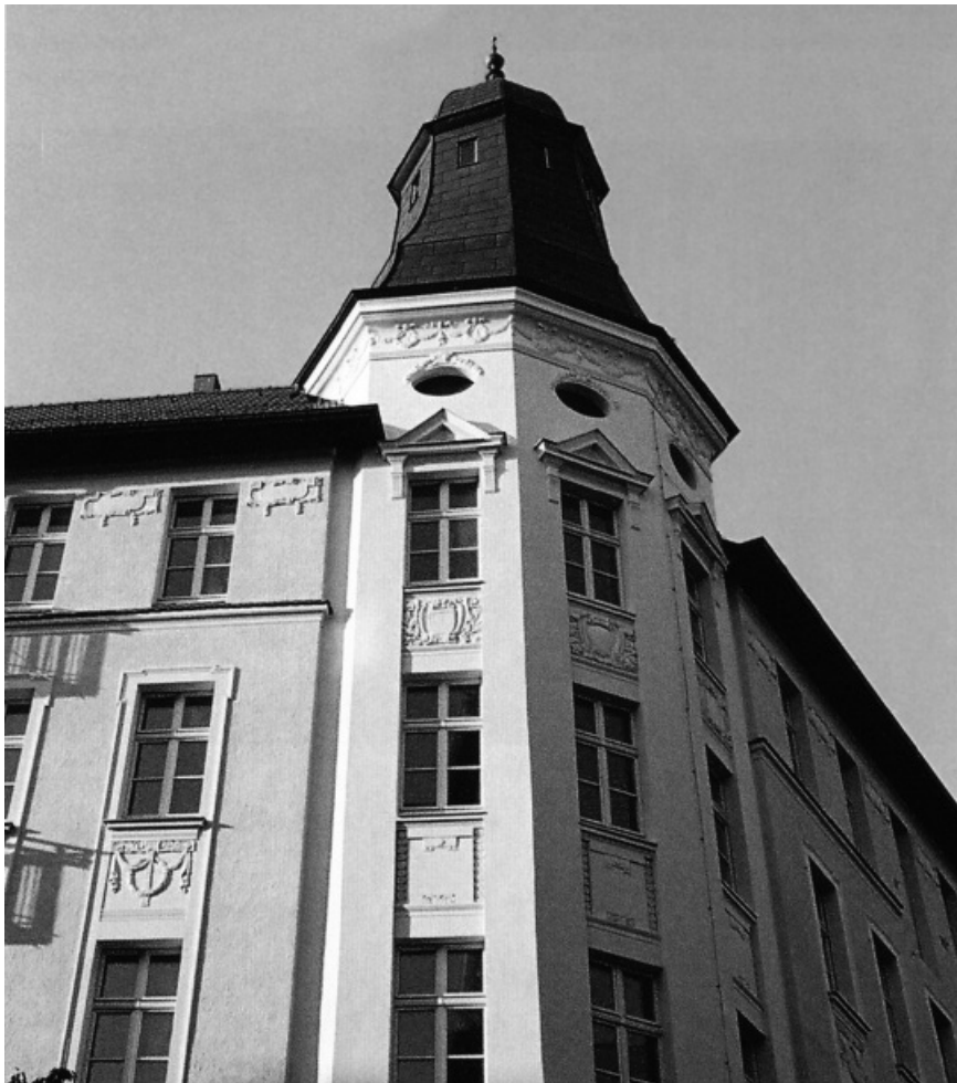
Restaurierte Fassade Gneiststraße / Ecke Pappelallee
