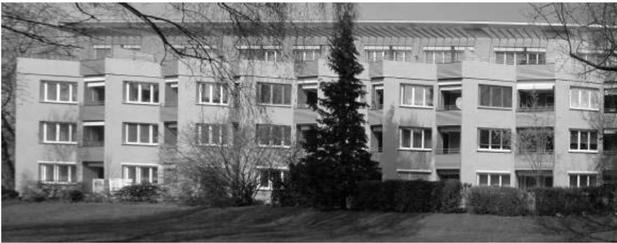
**Abb. 7: Sanierung im EnEV minus 50 %-Standard für den Bestand und Aufstockung mit sechs Passivhauswohnungen: Bernadottestraße in Nürnberg**
