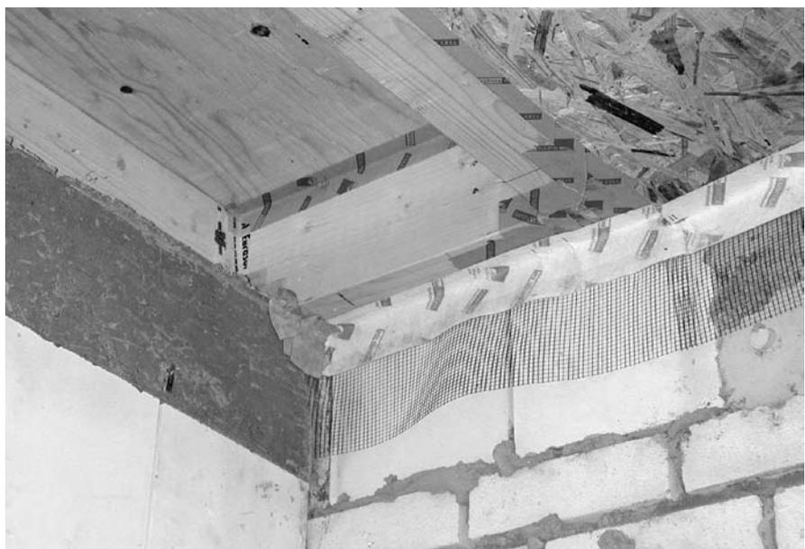
Ablebungen zur Sicherung der Luftdichtigkeit
