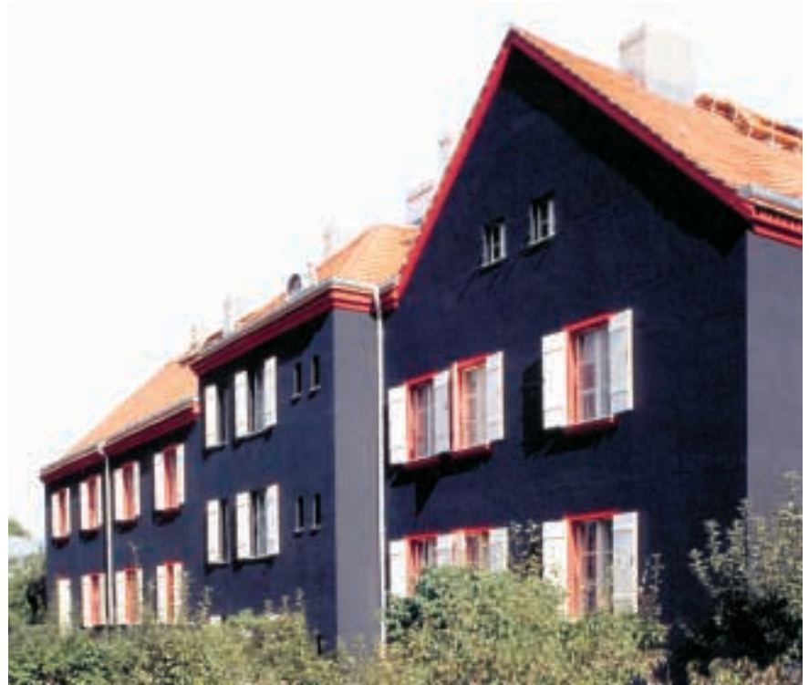
Gartenstadt Falkenberg, restaurierter Eingang und schwarzes Haus
