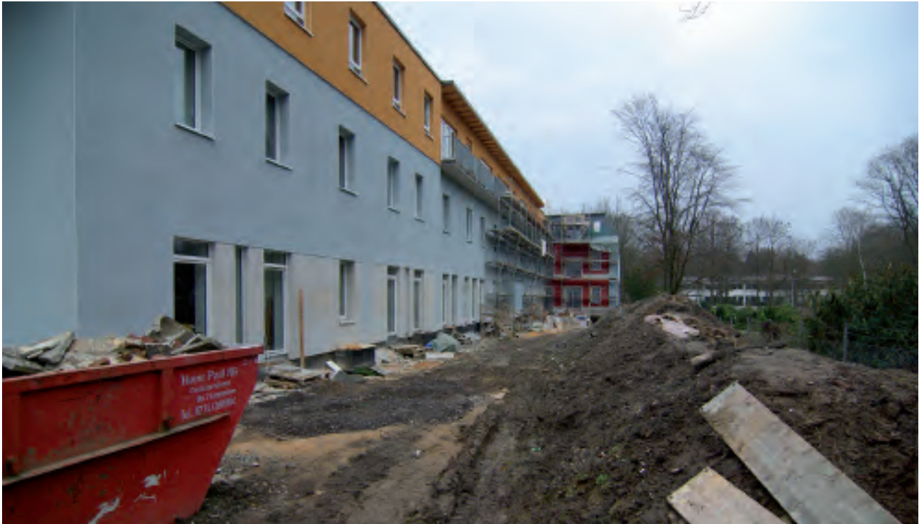
... ebenso wie die Umbaumaßnahmen im Projekt "buntStift" der Wohn-Raum eG in Bochum
