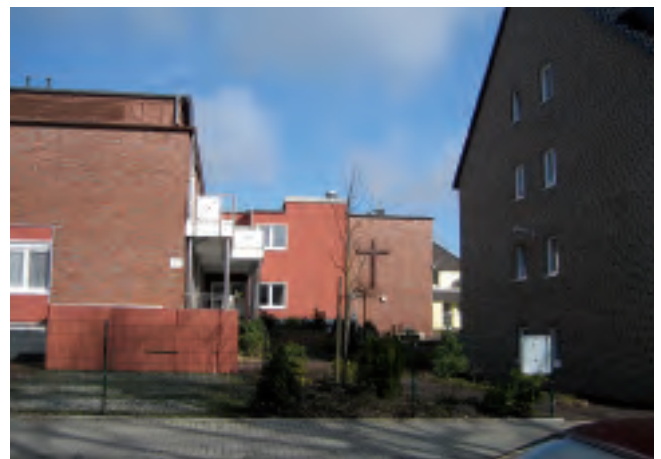
Eingangsbereich zum umgebauten Gemeindehaus Foto: Sabine Matzke
