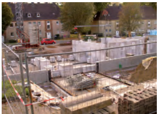
Mittleres und unteres Foto: Baustelle Südring 23, Hattingen, Projekt „wir wohnen zusammen e. V. / hwg eG
