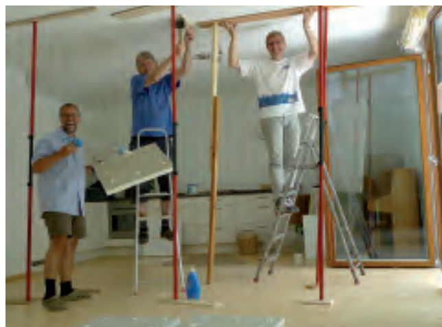
Südring 23: Innenausbau Isolierarbeiten
